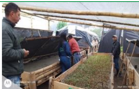
Foto 19. Construcción Vivero contrato 534-2023.- Vereda La Capilla -. Municipio: Cajibío
