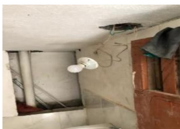
Foto 135. Instalaciones eléctricas en malas condiciones Vereda o sitio: Dirección Territorial Macizo Municipio: La Vega
