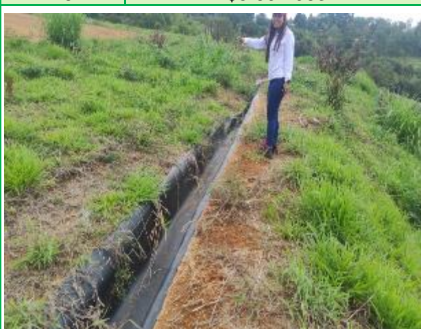
Foto 105. Sitio de disposición de RCD - Zanja de coronación Sitio: Villa Alejandra - Municipio: Piendamó
