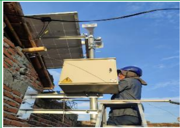
Foto 13. Instalación de sistemas de alerta sonoros - Sitio: Cabecera Municipal - Mpio: Guachené
